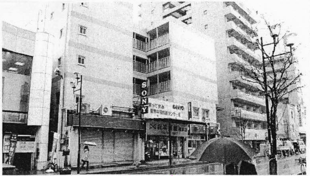
盛人大学が入る予定のビル。1階に電気店や交番、裏側に市立並木保育園がある。川口市のJ R西川口駅東口
