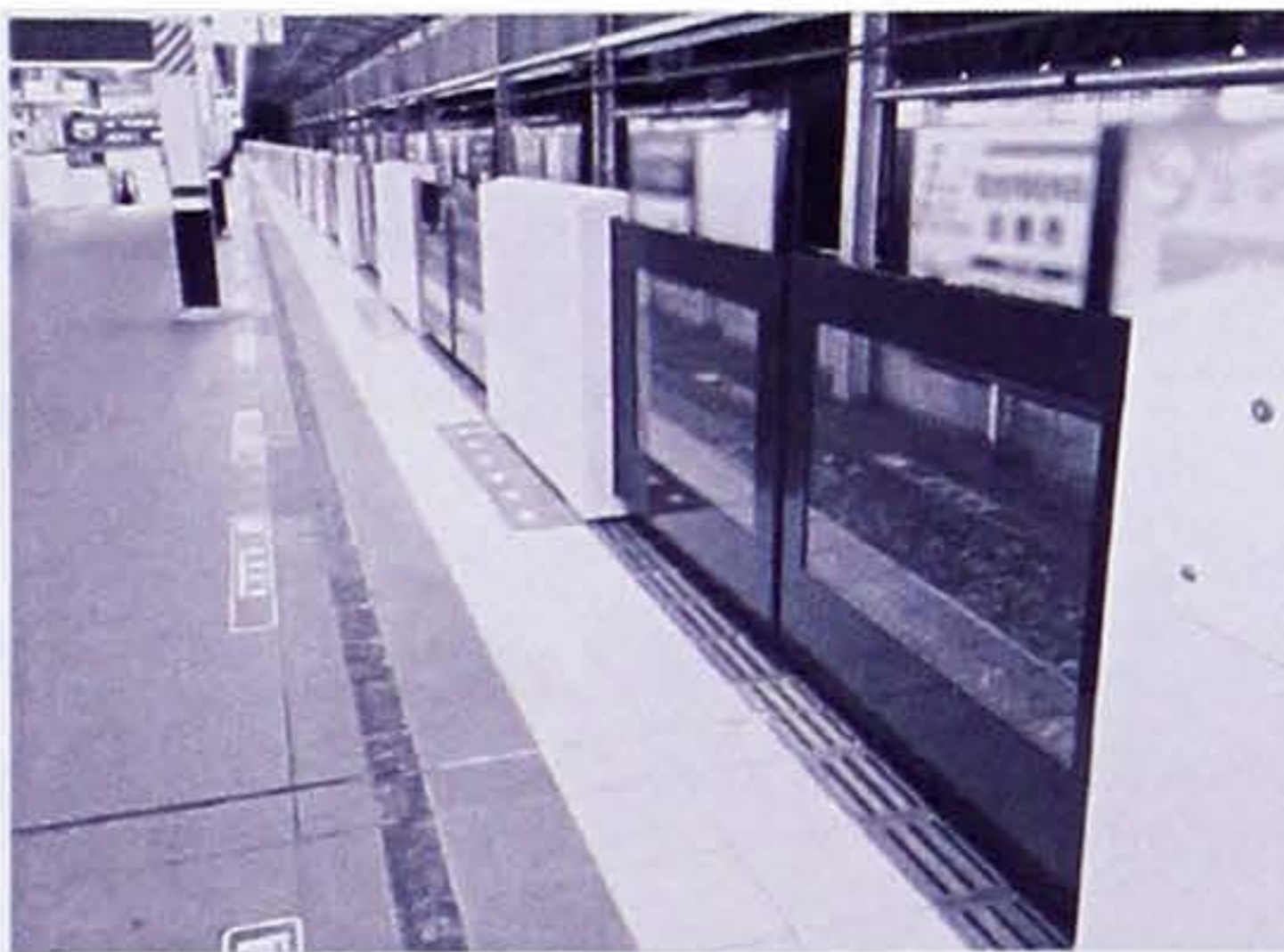
ホームドアの設置
