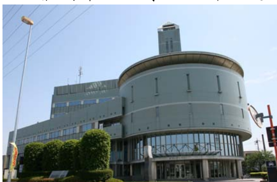
鳩ヶ谷市庁舎
